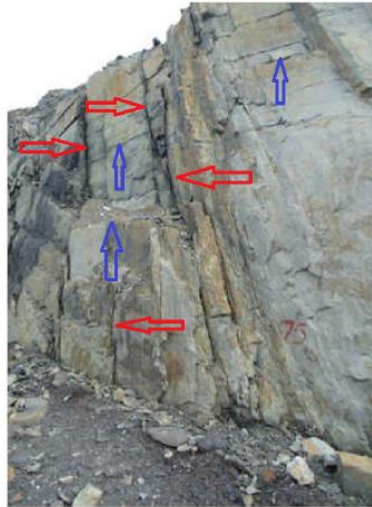
Figure 1: Representação de descontinuidades em um maciço rochoso. Fonte: Adaptado de Lana et al. (2019).
