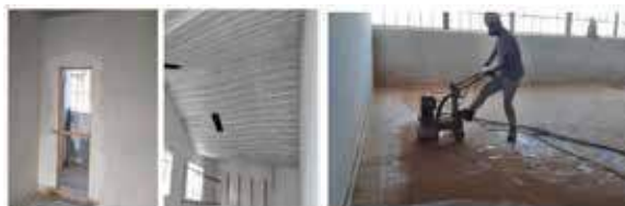
MANUTENÇÃO PAVILHÃO CENTRAL OURO PRETO
