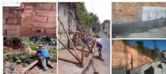
RECONSTRUÇÃO/ ESCORA DO MURO EM BETIM
