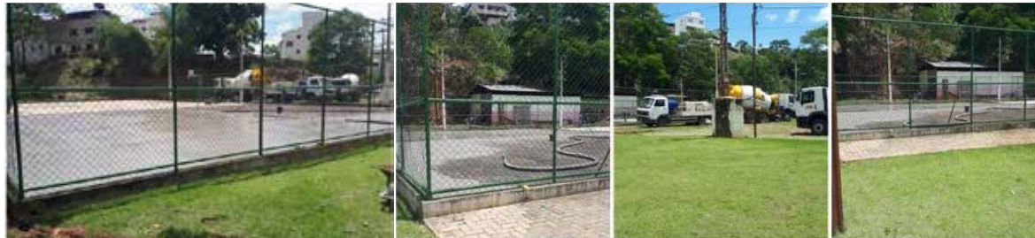
REFORMA DAS QUADRAS DE PONTE NOVA
