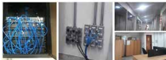
REITORIA SPCI, ELÉTRICA E CABEAMENTO ESTRUTURADO
