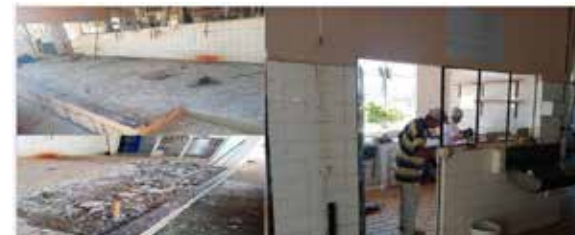
MANUTENÇÃO - FÁBRICA LATICÍNIOS BAMBUÍ
