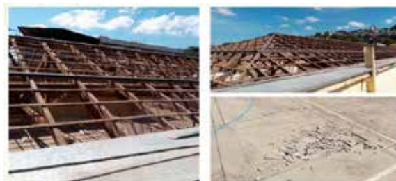
TELHADO PONTE NOVA
