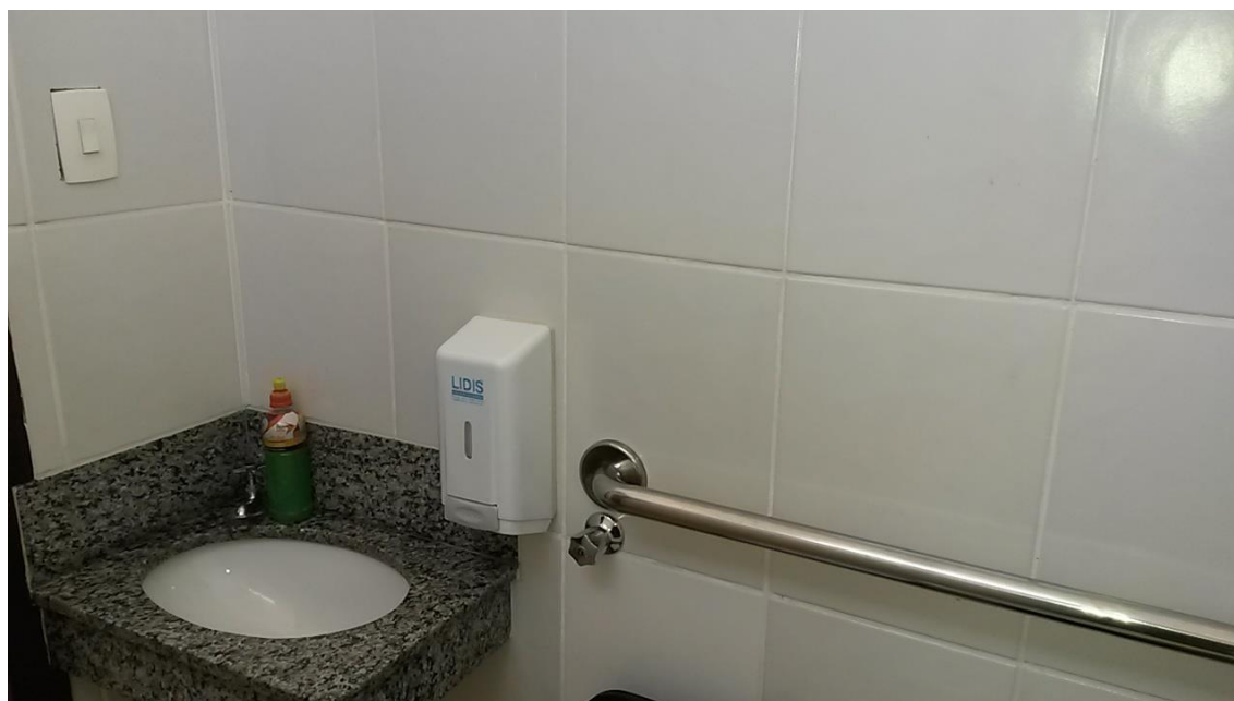
Figura 7 ó Detalhe do banheiro para P.N.E. - Barras de apoio instaladas.
