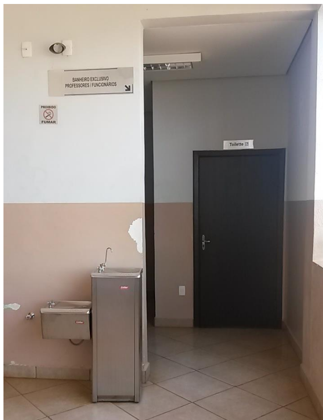
Figura 6 ó Vista geral do banheiro para P.N.E.
