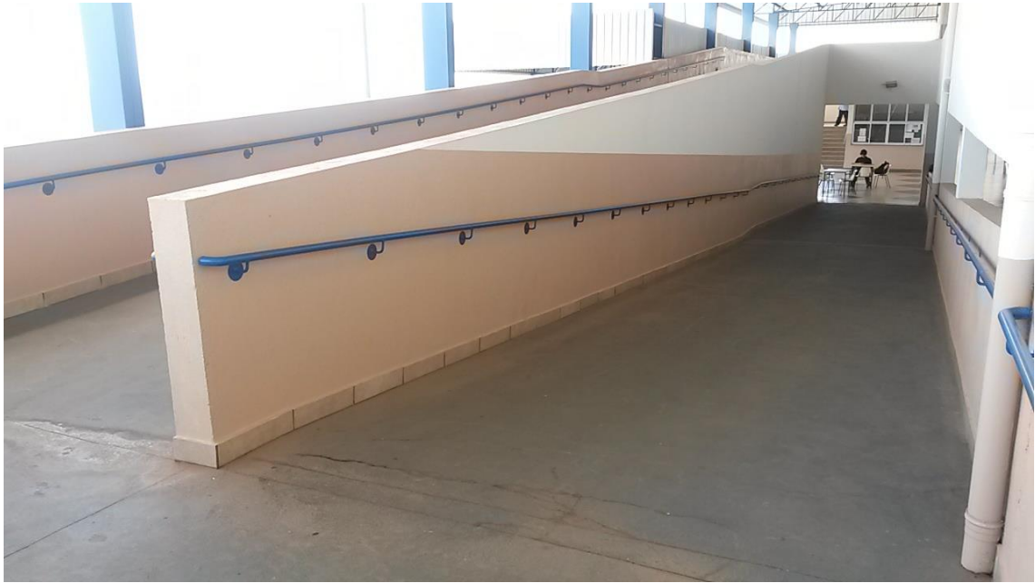
Figura 2 ó Rampa de acesso ao segundo andar
