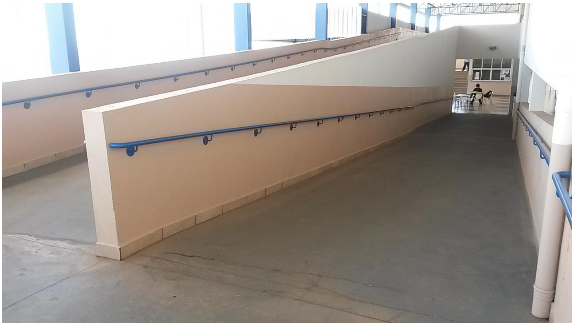
Figura 6 - Rampa de acesso ao segundo andar
