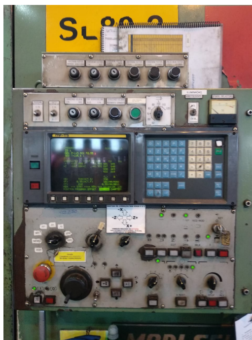
Figura 12 – Painel de Operação antes da reforma. Fonte: Arquivo próprio.
